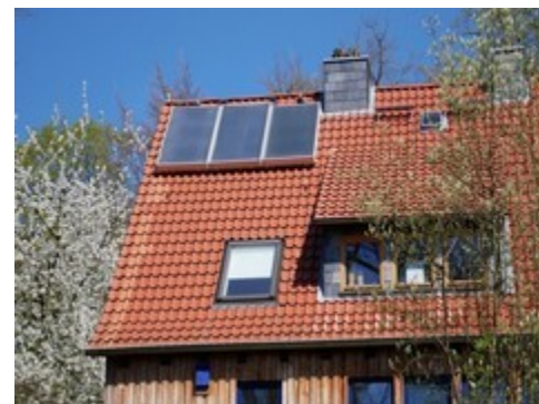
Solarthermieanlage auf neu gedämmten Wohnhaus – gASTWERKe e.V.
