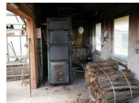
Holz, als nachwachsender Rohstoff, wird auf dem Gelände gesägt, gespaltet und für den 100 KW Holzvergaserofen aufbereitet.
